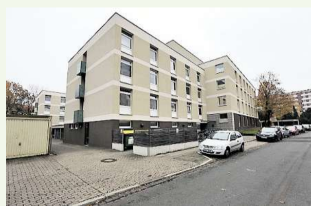
WURDE 2011 SANIERT: Das Studentenwohnheim an der Hufelandstraße in Limmer.
